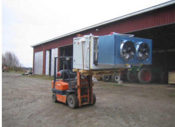
IDN 1000 TECHNOBLOCK kylmäkoneen asennus porkkanavarastoon - syksy 2007
