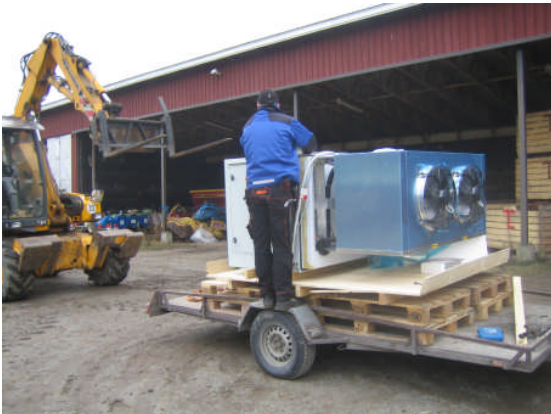
IDN 1000 TECHNOBLOCK kylmäkoneen asennus porkkanavarastoon - syksy 2007
