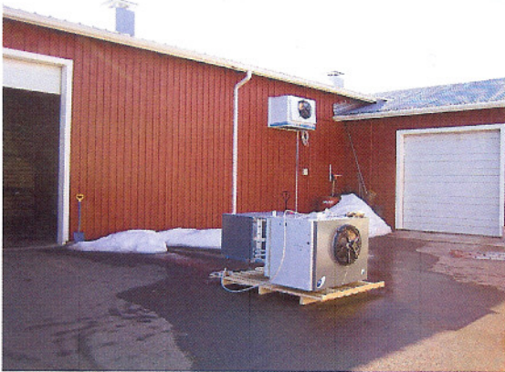
IDN 400 kylmäkone valmiina asennettavaksi kylmävaraston seinään. MYLLYVAINION PERUNA Kalajoki
