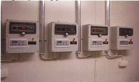
Käyttöpaneelit 0,1 C ° tarkkuus (koneissa myös lämmitys Sopii mainiosti esim. SIPULILLE )
