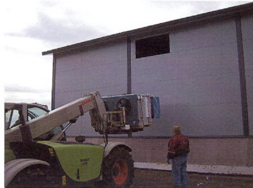
SUURI PORKKANAVARASTO 50 x 16 x 5.5 m 4400m 3 4 x IDN 2000 kylmäkonetta
